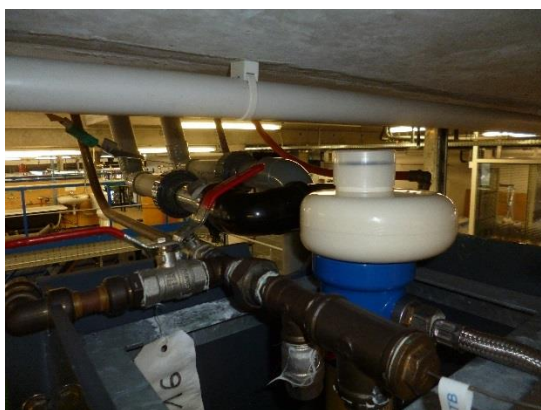
Raccordement de l'entrée des eaux de douche
