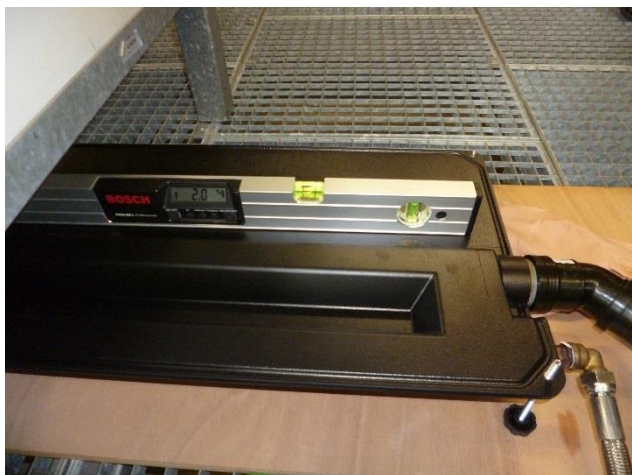
Mise à niveau de l'échangeur
