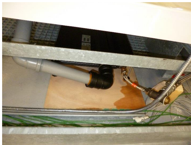
Raccordements de l'entrée des eaux de douche et de la sortie de l'eau préchauffée
