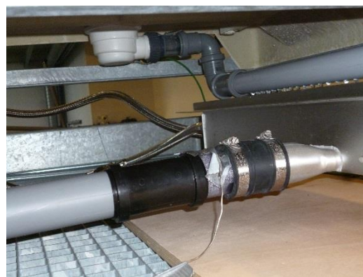
Raccordement de la sortie des eaux de douche
