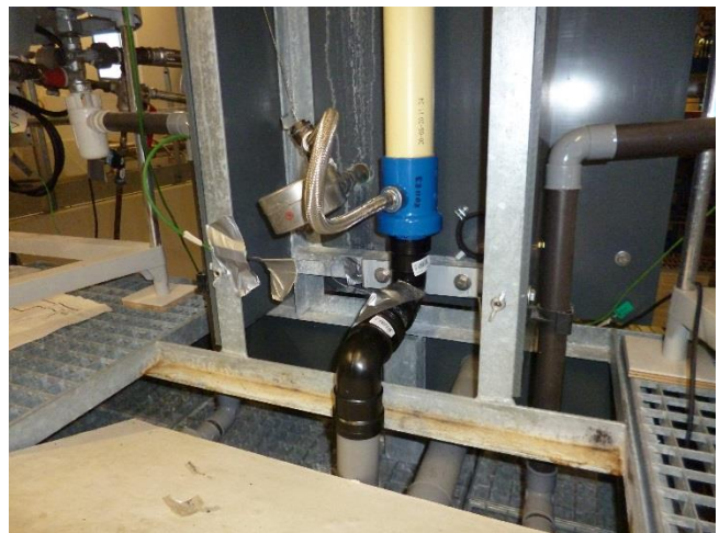
Raccordement de l'entrée d'eau froide et de la sortie des eaux de douche
