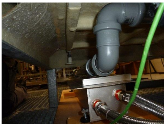
Raccordements de l'entrée d'eau froide et de la sortie de l'eau préchauffée
