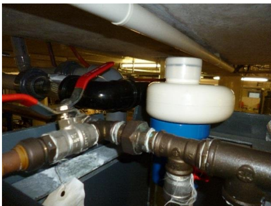
Raccordement de l'entrée des eaux de douche
