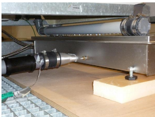
Raccordement de la sortie des eaux de douche
